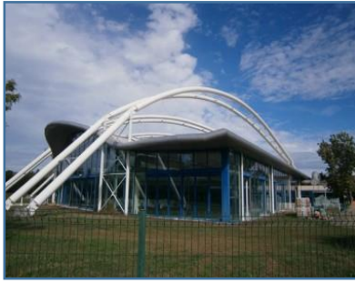
Figure 4. Vue générale de la zone d'inspection
