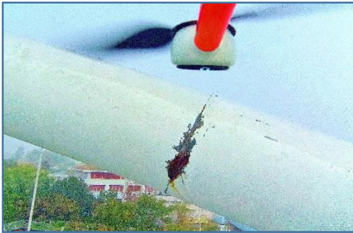
Figure 5. Photographie de soudure douteuse
